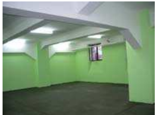
Lavori giugno 2008 (pavimenti non ancora realizzati)
